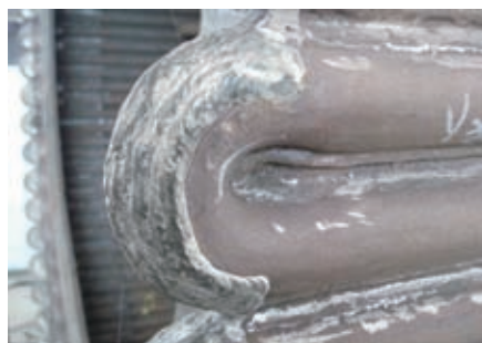
图10 气化炉内件管子堆焊
