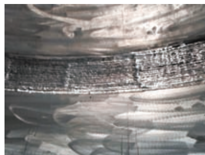
图11 气化炉外壳堆焊
